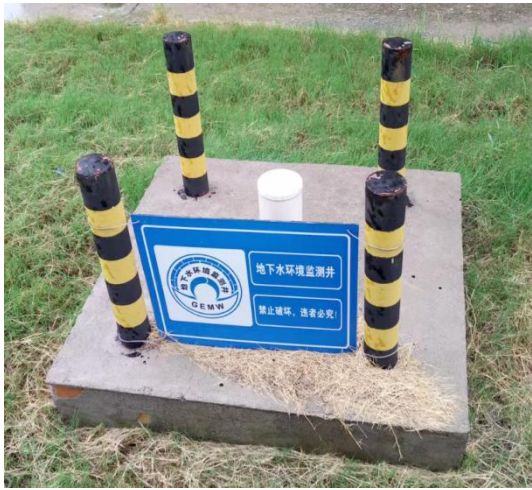
地下水监控井
