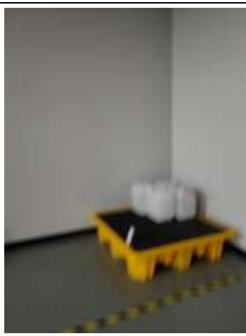
危废间防渗地坪+托盘
