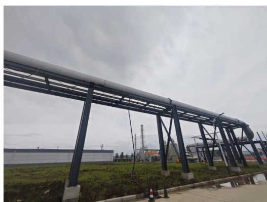
车间废气、罐区废气、危废库废气收集管道
