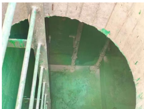
雨水池防渗照片
