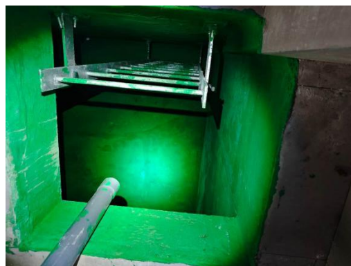
污水站防渗照片
