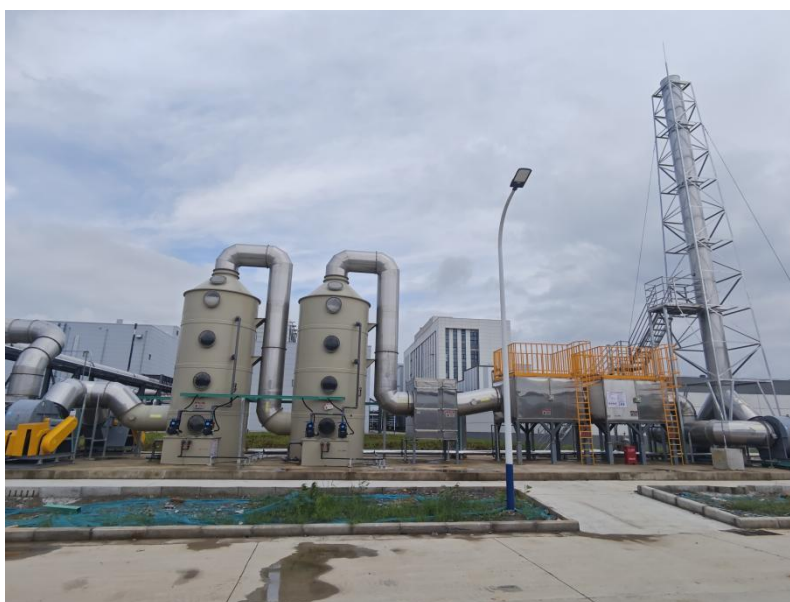
二级水洗+干式过滤+二级活性炭吸附装置
