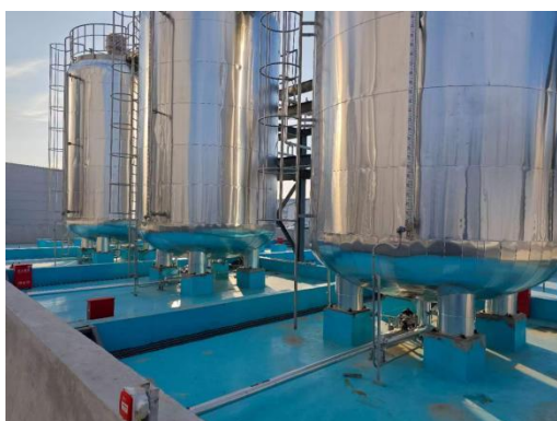
罐区防渗照片
