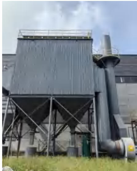
旋风+脉冲布袋除尘器、熔铸生产线废气排气筒
