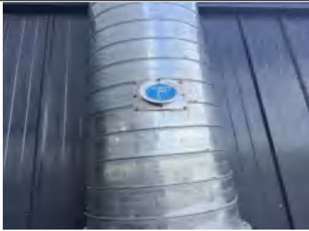
污水站排气筒采样平台及采样孔
