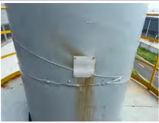
熔铸线排气筒采样平台及采样孔
