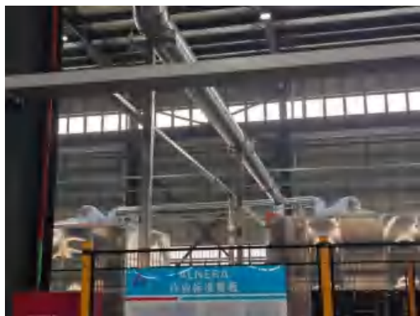
焊接、补焊废气收集管道及排气筒
