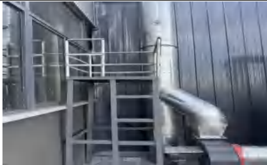
污水站排气筒采样平台及采样孔
