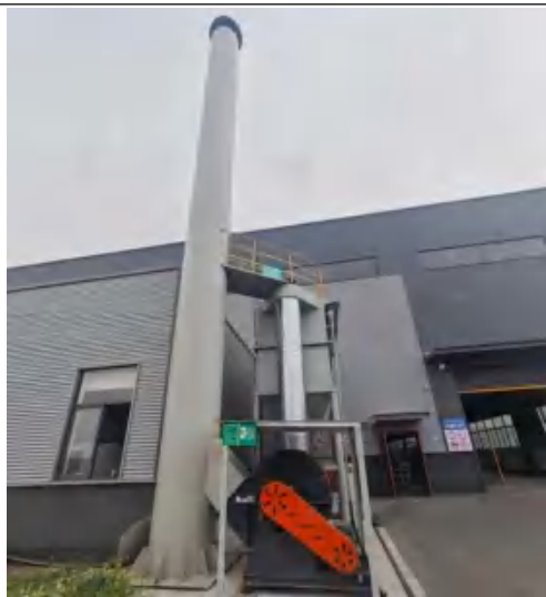
焊接、补焊废气收集管道及排气筒
