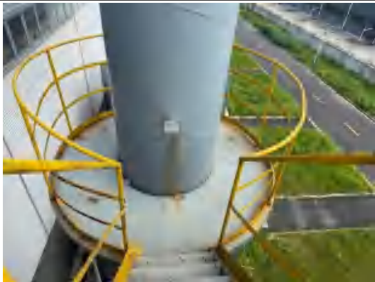
熔铸线排气筒采样平台及采样孔
