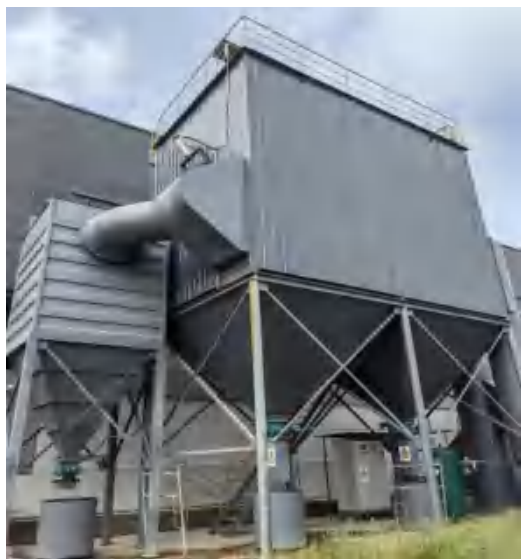
旋风+脉冲布袋除尘器、熔铸生产线废气排气筒
