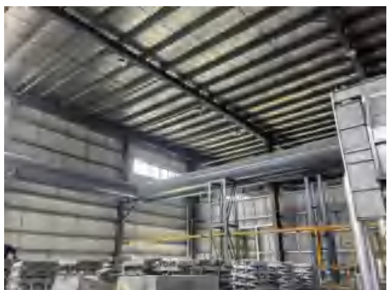
熔铸生产线车间集气罩及收集管道
