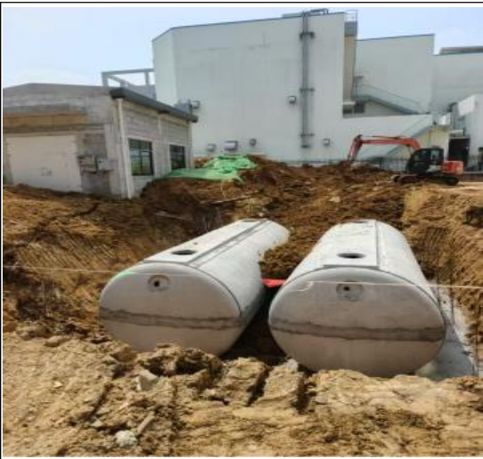
事故池施工照片
