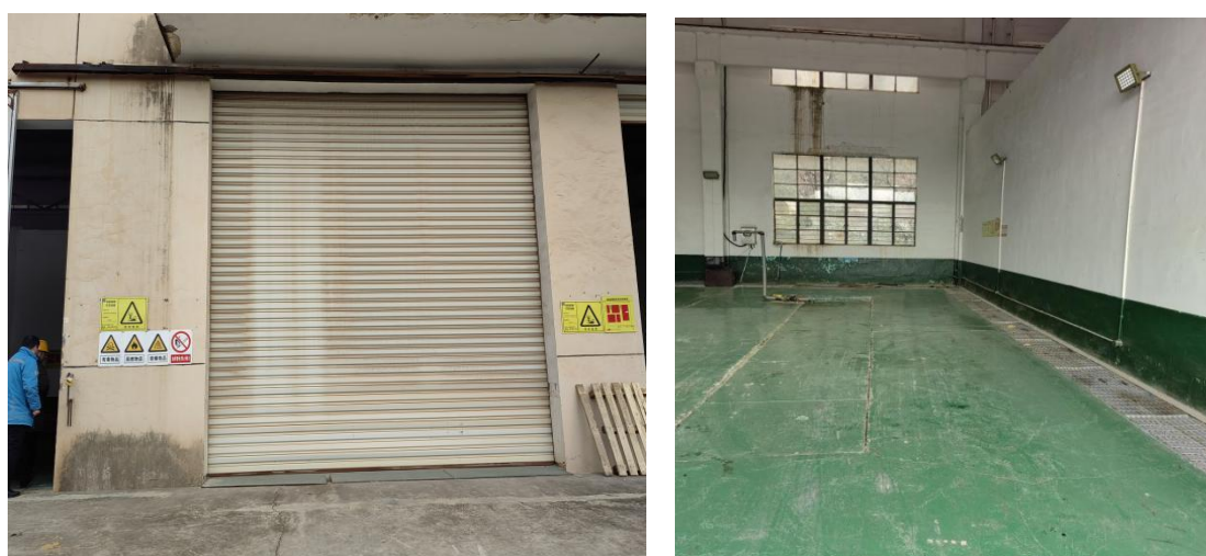
危废暂存间照片
