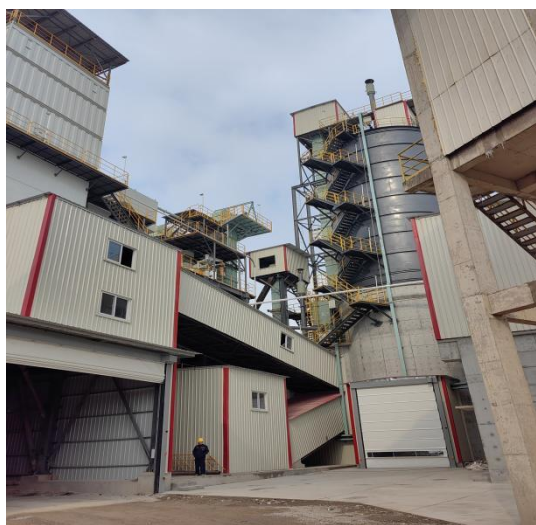
废气密闭、排气筒
