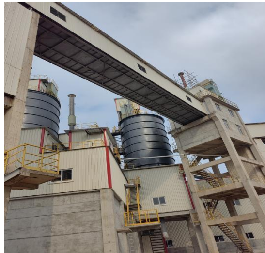
废气密闭、排气筒
