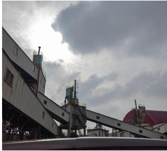
废气密闭、排气筒
