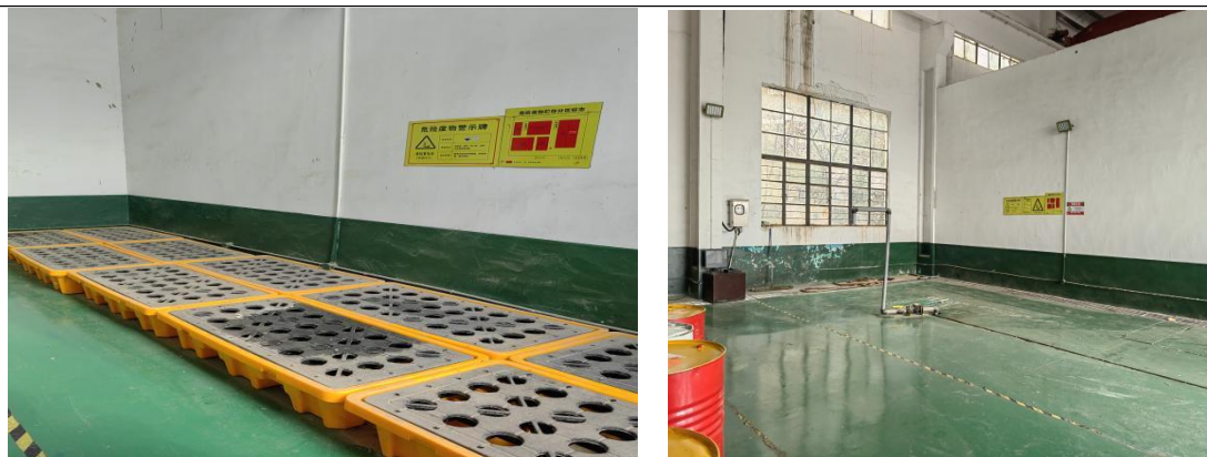
危废暂存间照片
