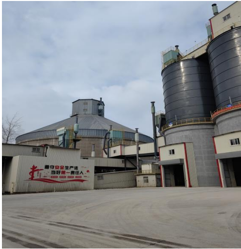
废气密闭、排气筒、硬化地面
