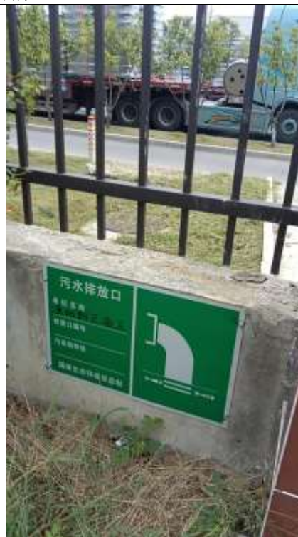
废水排放口标牌
