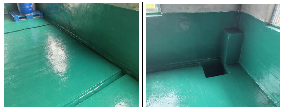
危废暂存库内部导流槽、收集池
