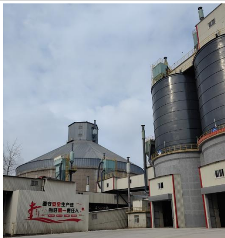
排气筒消音器
