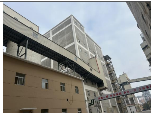
输送皮带密闭廊道
