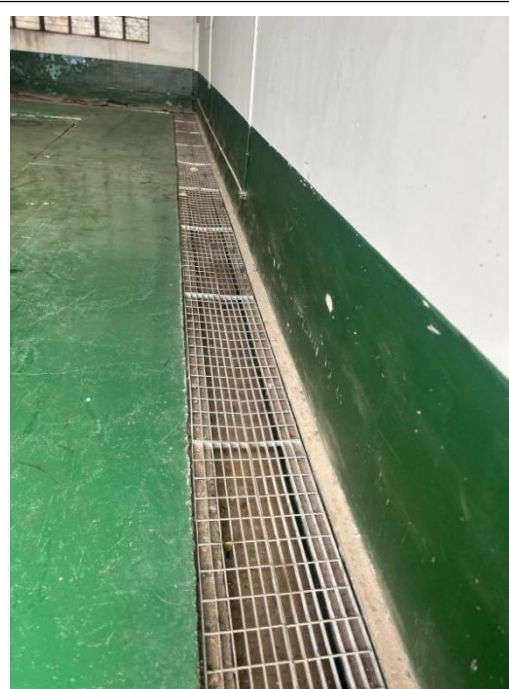
危废暂存间照片
