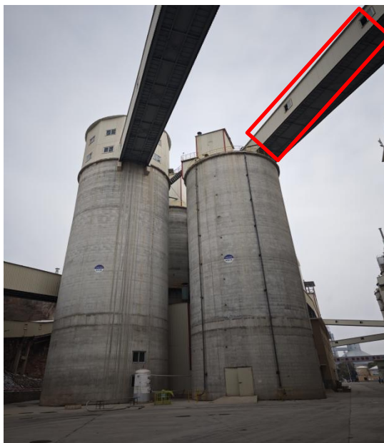
仓顶密闭输送廊道
