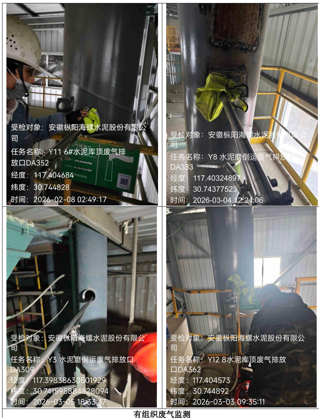
附图 4 部分现场监测照片
