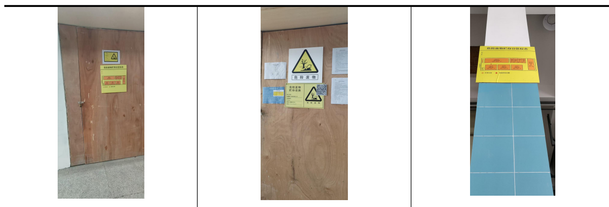
图 4.1-4 本项目危废暂存间
