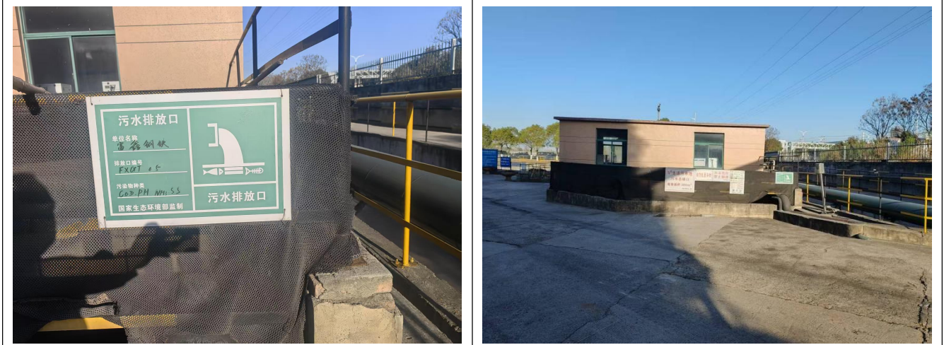
生活污水排放口
