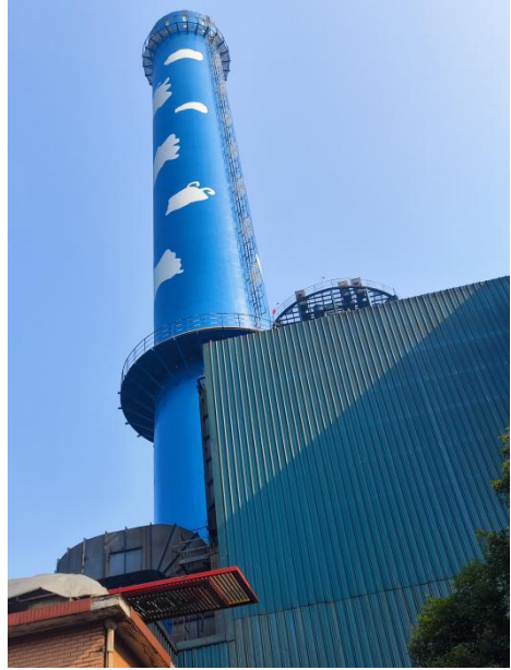
“五电场除尘+两级湿法脱硫（2#、3#脱硫塔）+湿电复合除尘+GGH 换热加热系统+SCR 脱硝工艺”+DA001 排气筒
