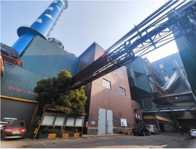
“五电场除尘+两级湿法脱硫（2#、3#脱硫塔）+湿电复合除尘+GGH 换热加热系统+SCR 脱硝工艺”+DA001 排气筒
