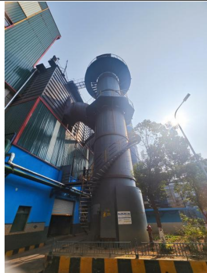
废气排气筒+检测平台
