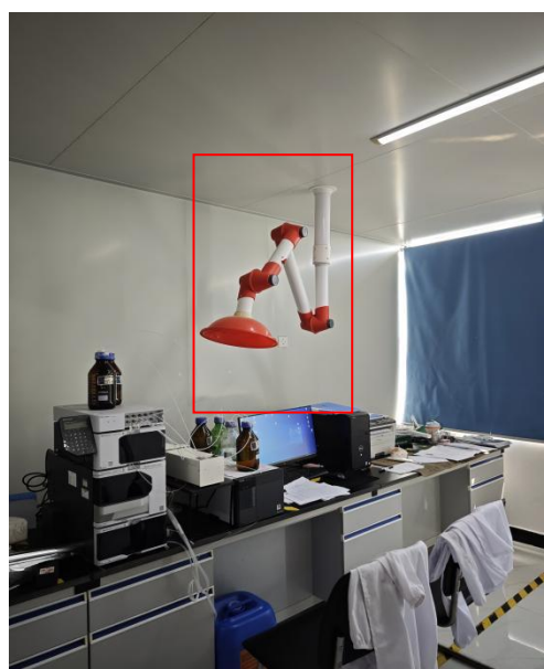
有机类仪器检测废气收集罩
