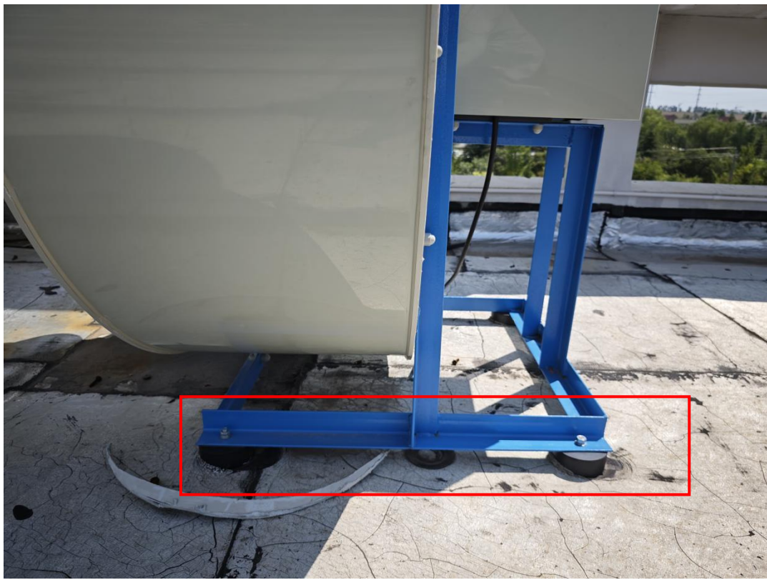
楼顶废气处理设施减震装置
