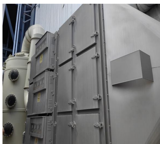
水喷淋+除雾器+电捕油+活性炭吸附装置（TA002）
