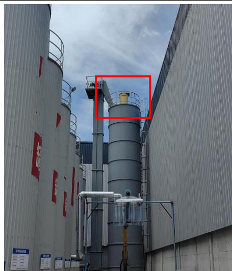
矿粉仓仓顶自带滤筒式袋式除尘器
