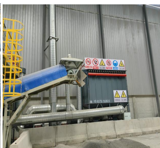
旋风除尘+布袋除尘装置（TA003）
