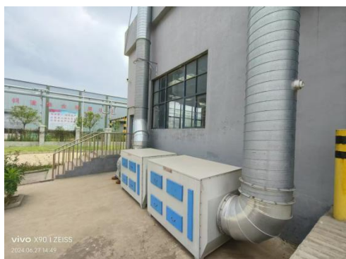
首矿大昌原有危废暂存间、废气处理设施及排气筒
