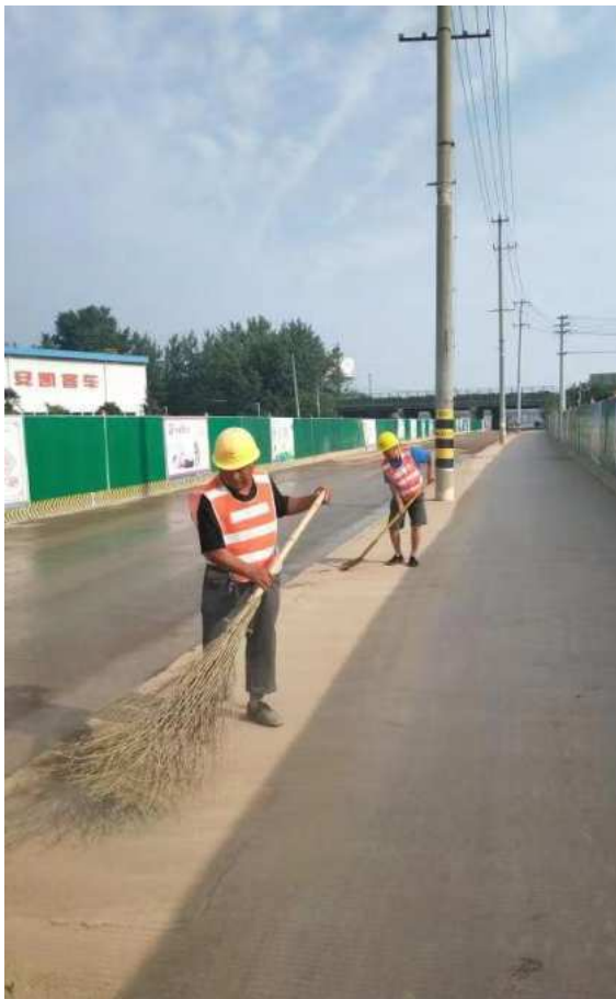
施工期路面清扫
