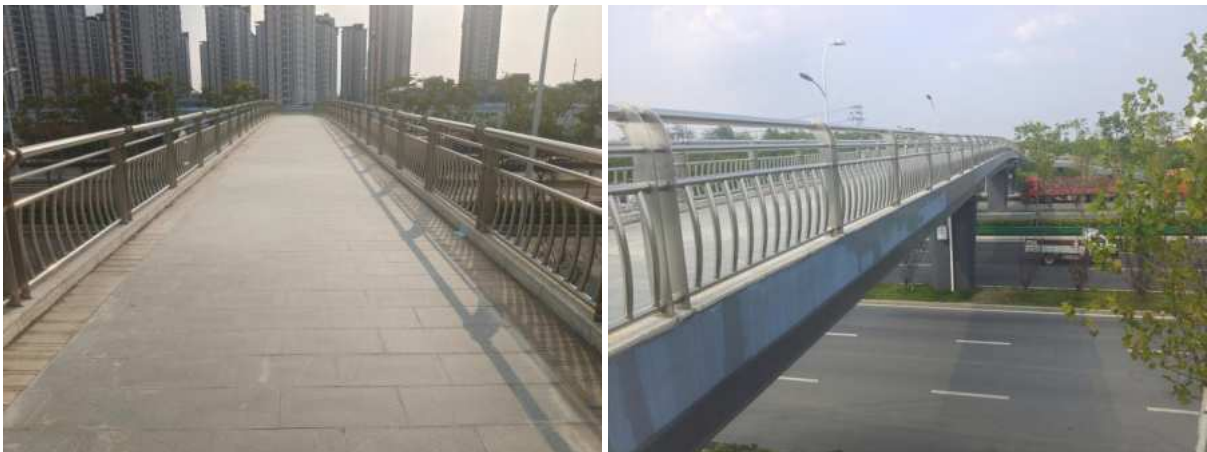
安凯厂人行天桥
