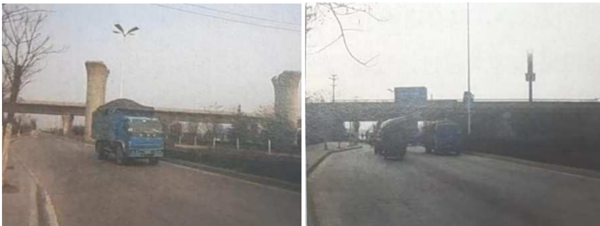
道路下穿高铁、高速原状
