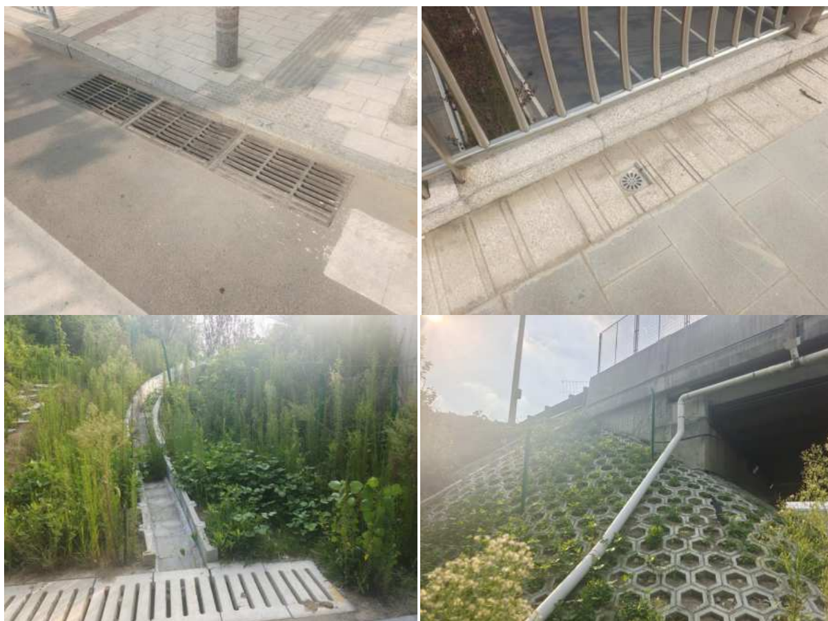
运营期路面排水及桥面排水工程
