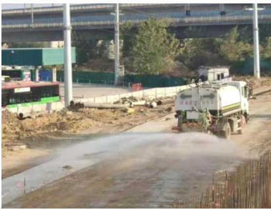
施工期路面洒水
