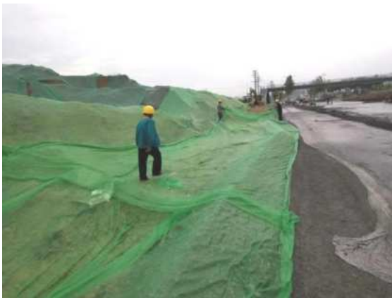
施工期物料覆盖
