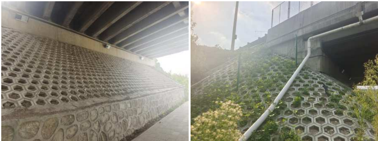
运营期边坡防护工程
