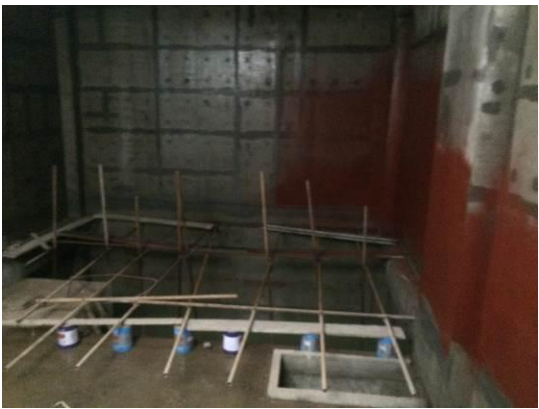
渗滤液收集池防渗施工现场
