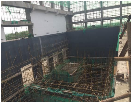
垃圾仓四壁防渗施工现场
