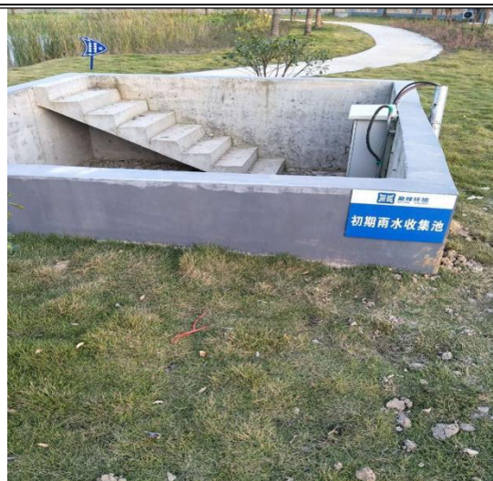
初期雨水收集池
