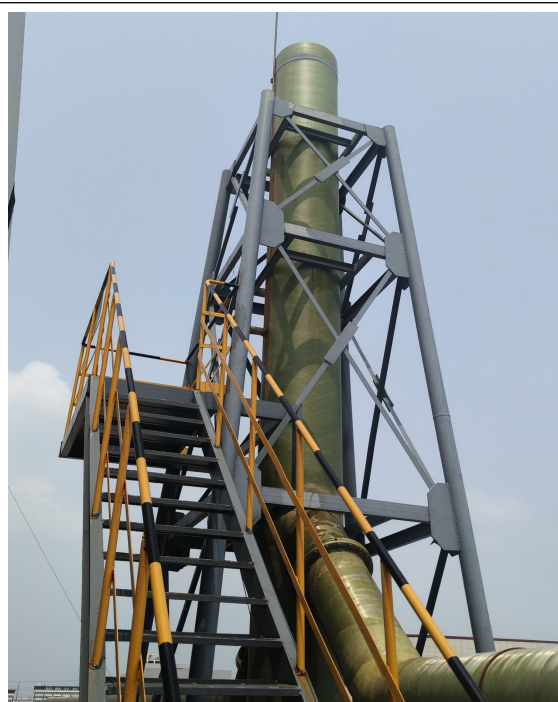
曼海姆炉燃烧废气排气筒
