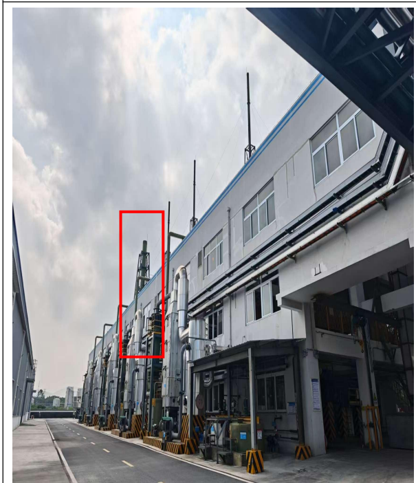
曼海姆炉燃烧废气排气筒
