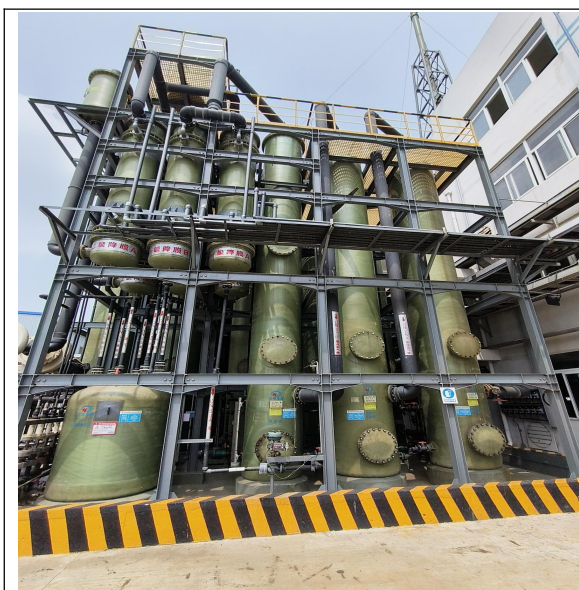
曼海姆炉高温冷却废气处理设施
