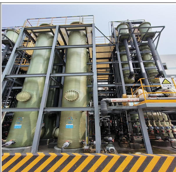
曼海姆炉高温冷却废气处理设施
