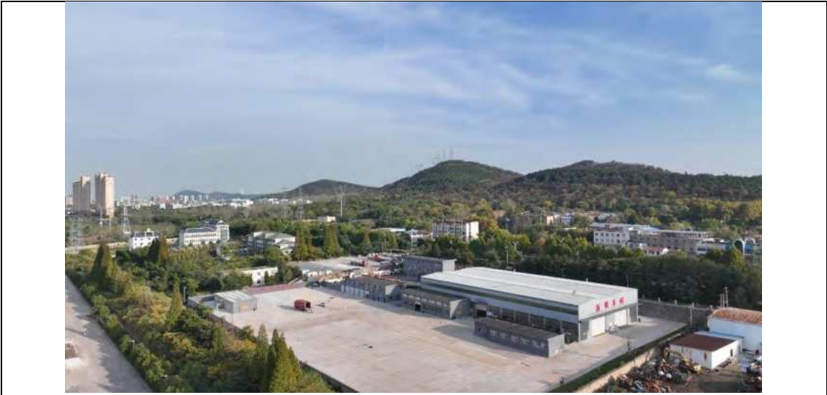
2024 年 11 月（现场航拍图）
