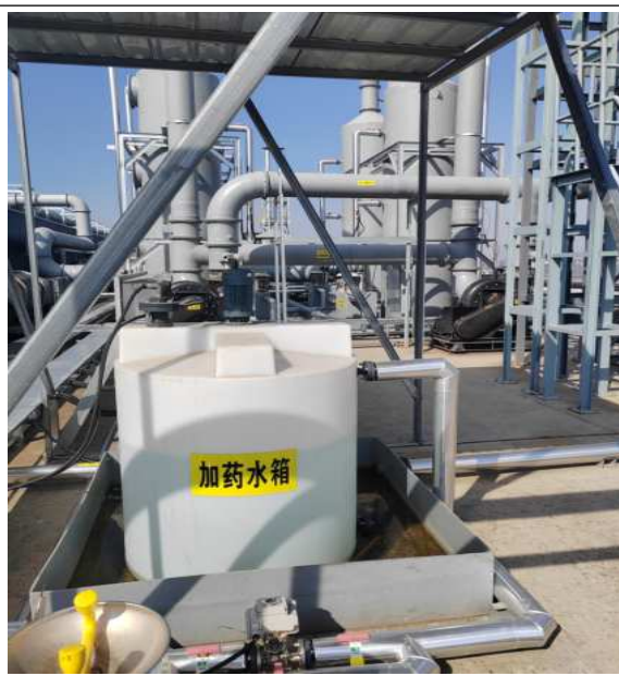
二级碱性喷淋废气处理设施
