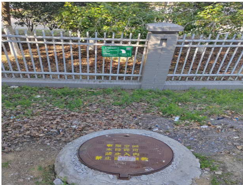
废水排放口标识牌
