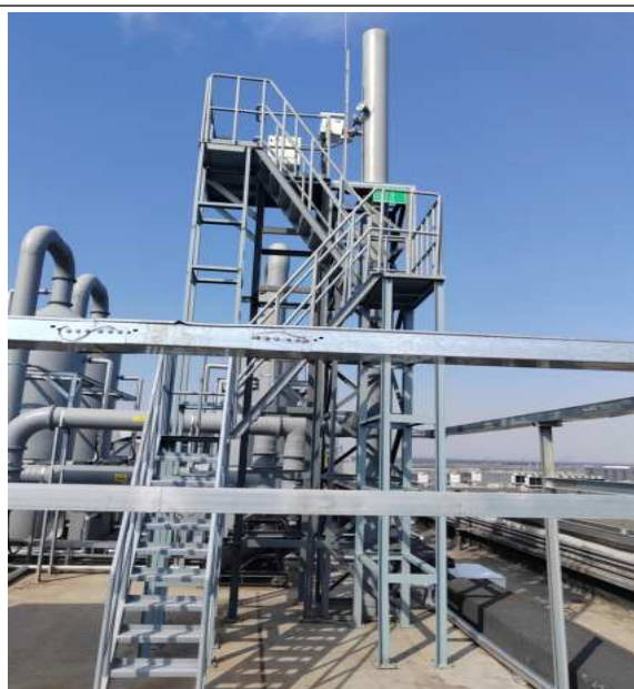
二级碱性喷淋废气处理设施
