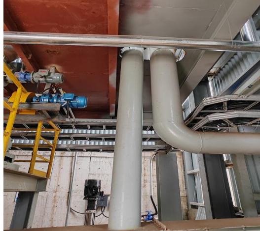
密闭除灰仓及其废气管道
