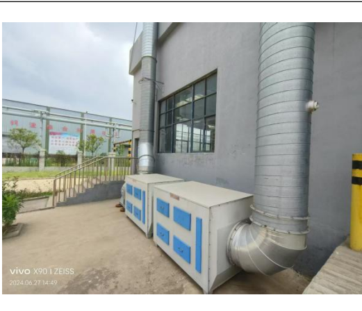
危废库废气处理装置
