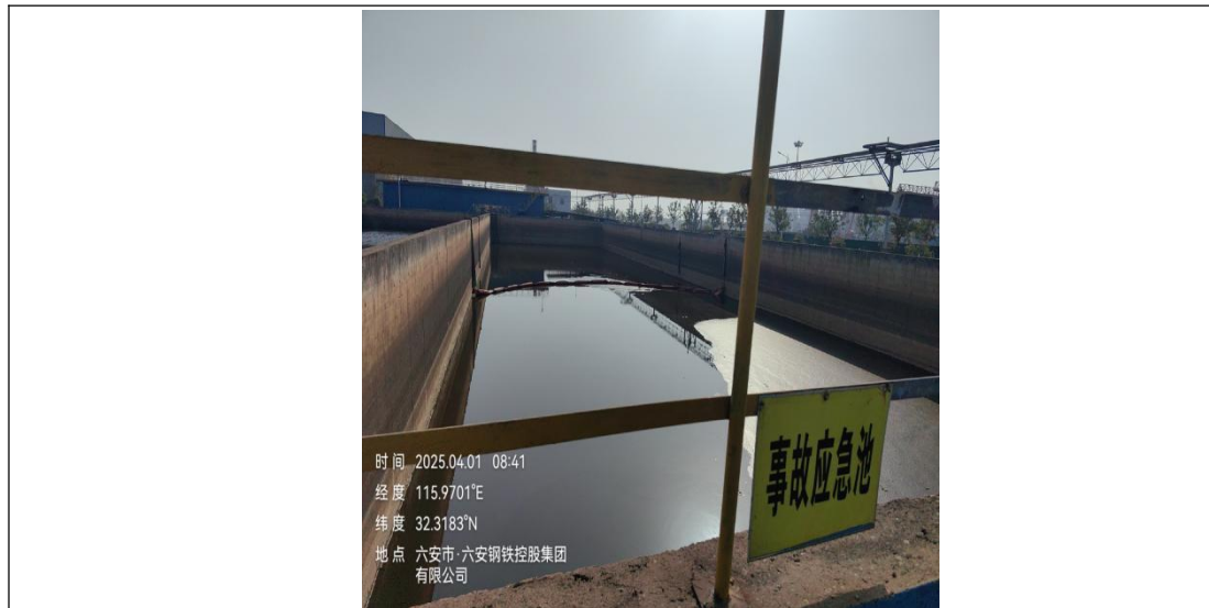
厂区原水处理设施南侧事故应急池
