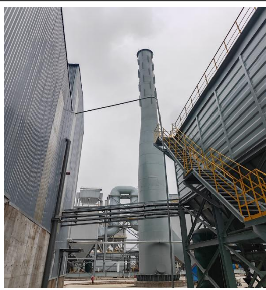
含尘废气布袋除尘器及其排气筒（DA089）
