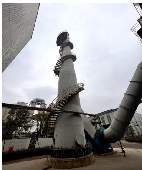
含尘废气排气筒标识牌+采样平台（DA089）
