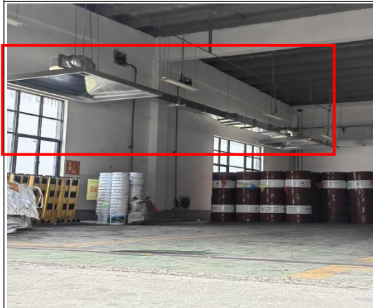
危废库废气处理装置
