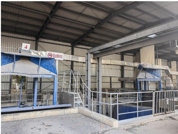
污泥仓密闭改造后
