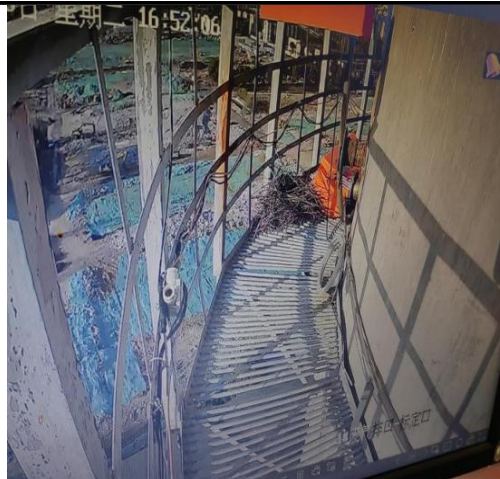
废气排放口采样平台
