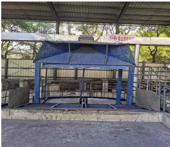
污泥仓改造前
