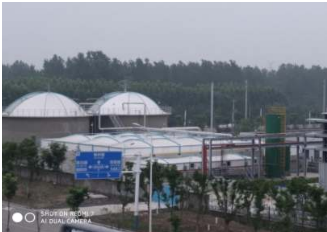
厂区污水处理站-整体概貌
