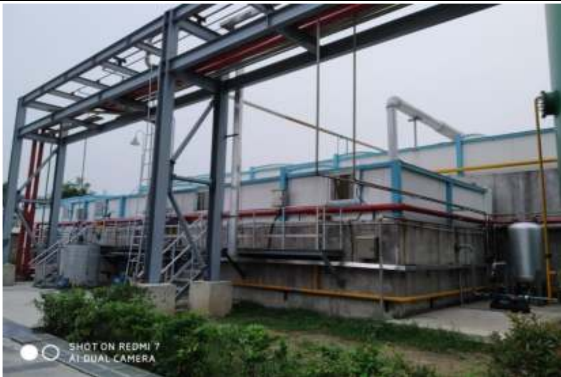
厂区污水处理站-调节池
