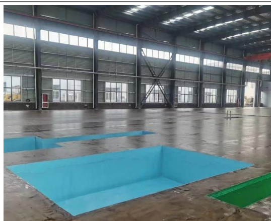
环氧树脂浆层面层施工
