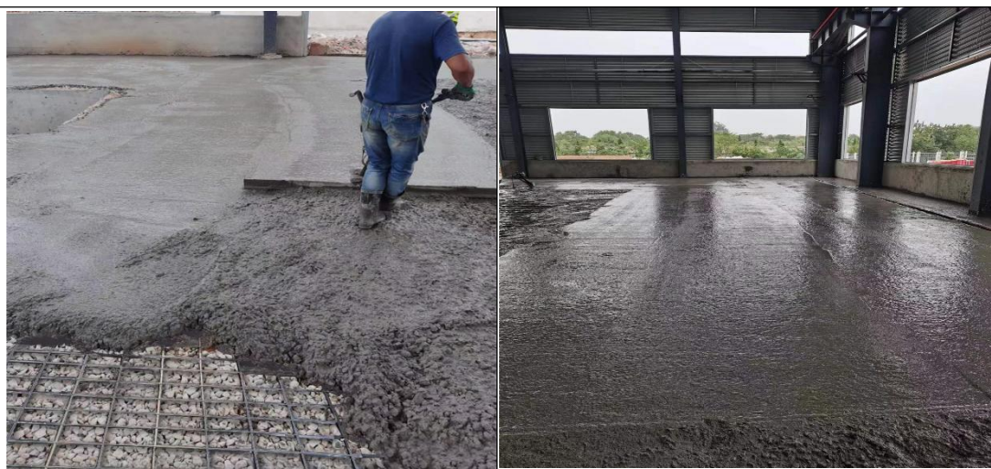
土木布上铺砂石、钢筋及水泥浇筑
