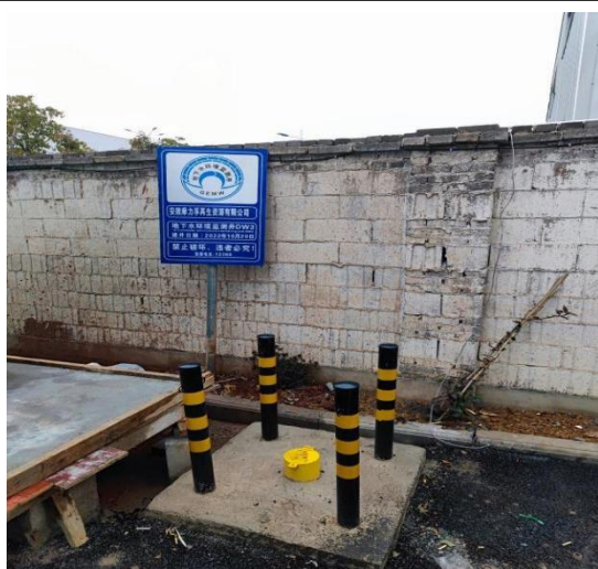
3#地下水监测井
