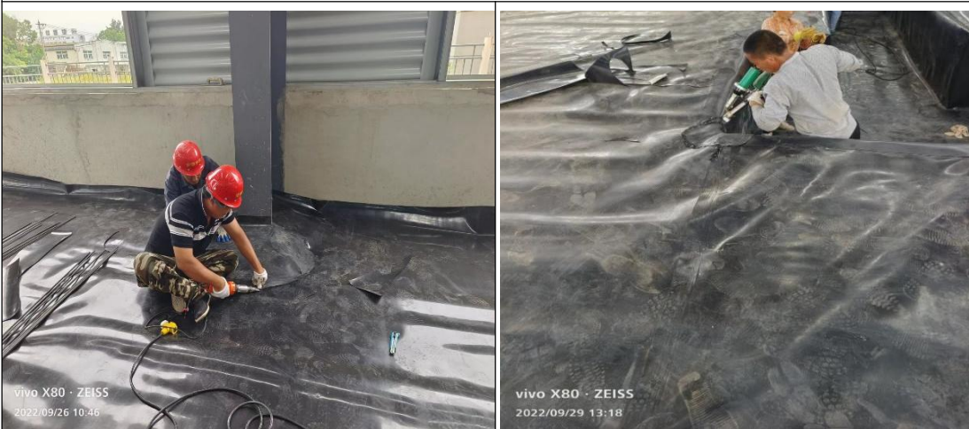
土工膜铺设、焊接
