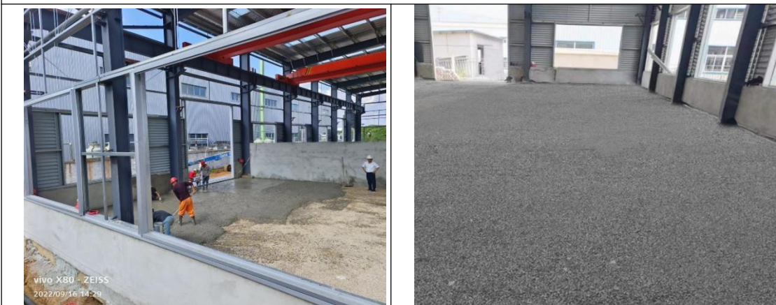
土层上铺沙及混凝土基层浇筑
