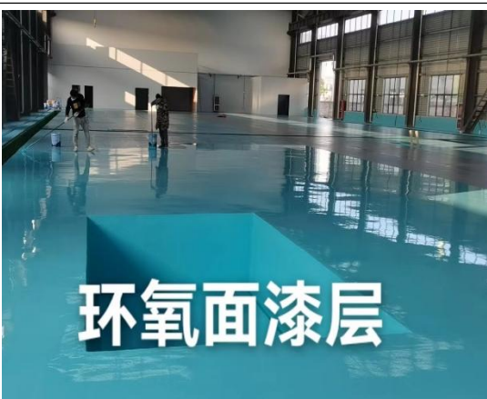
环氧树脂浆层面层施工
