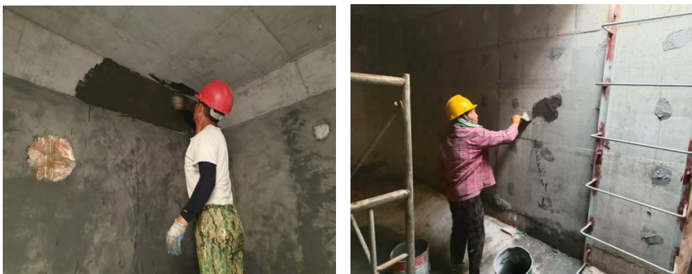
事故池防渗施工照片
