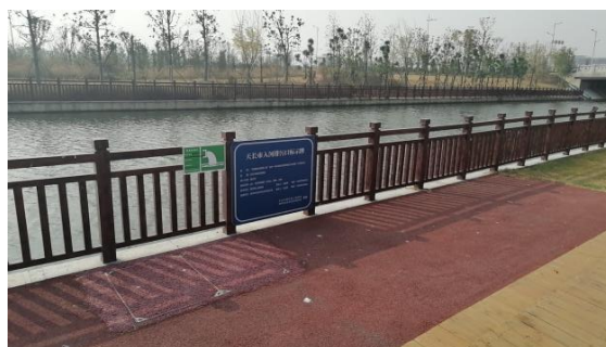
人工湿地排口标识牌
