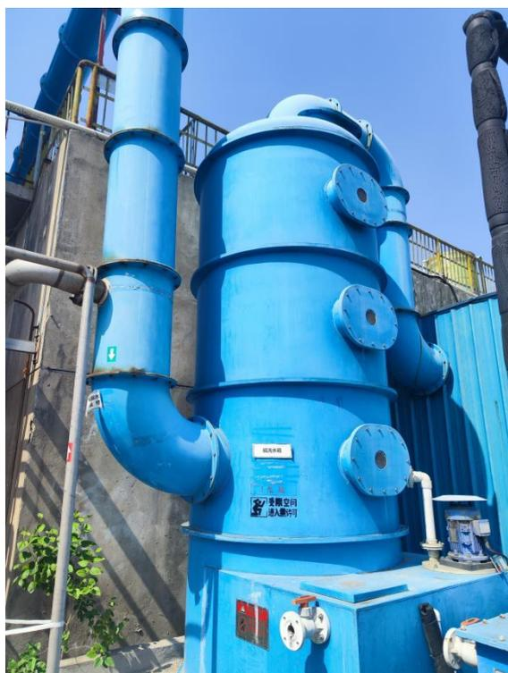
污水处理站废气碱洗装置
