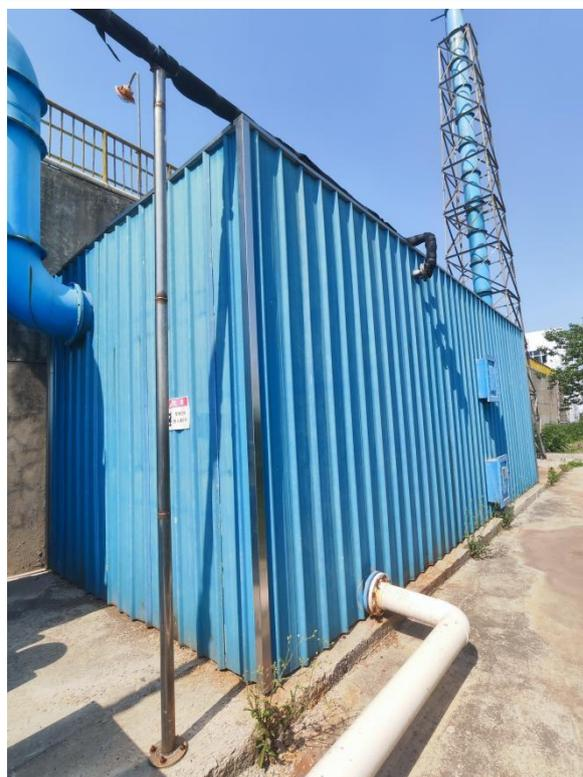
污水处理站废气生物除臭装置
