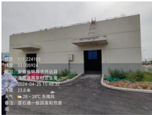
一般固废库和危险废物暂存库
