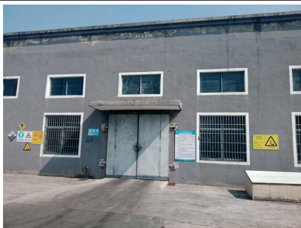
危废间标识牌
