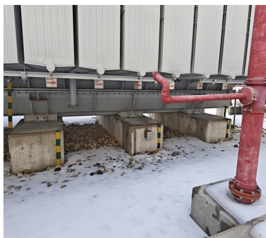
主变底部减振基座
