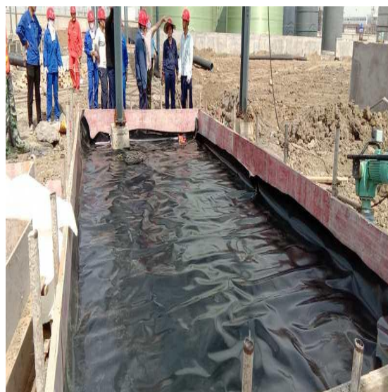
罐区泵围堰
