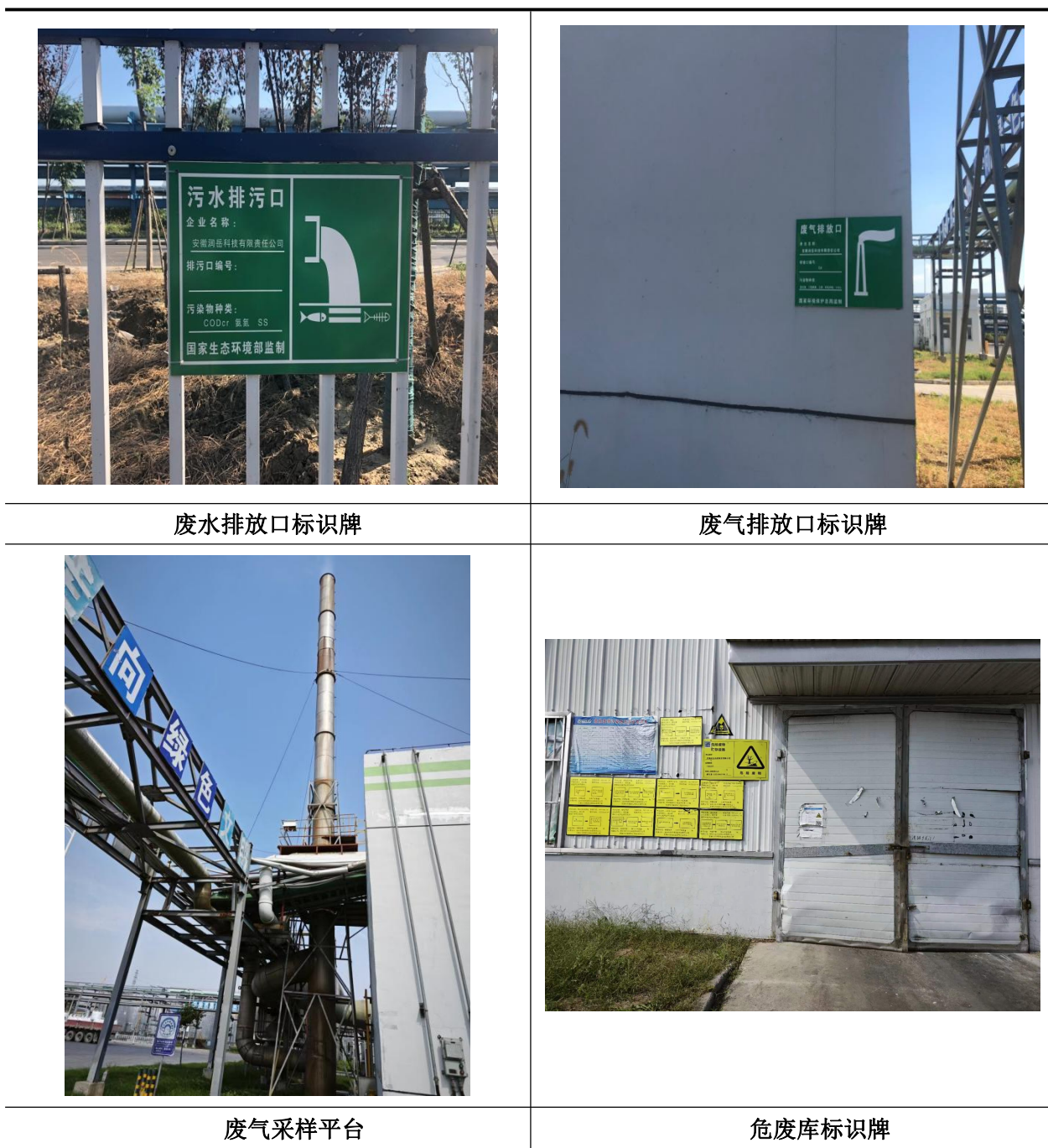
图 4.2-5 排放口规范建设照片
