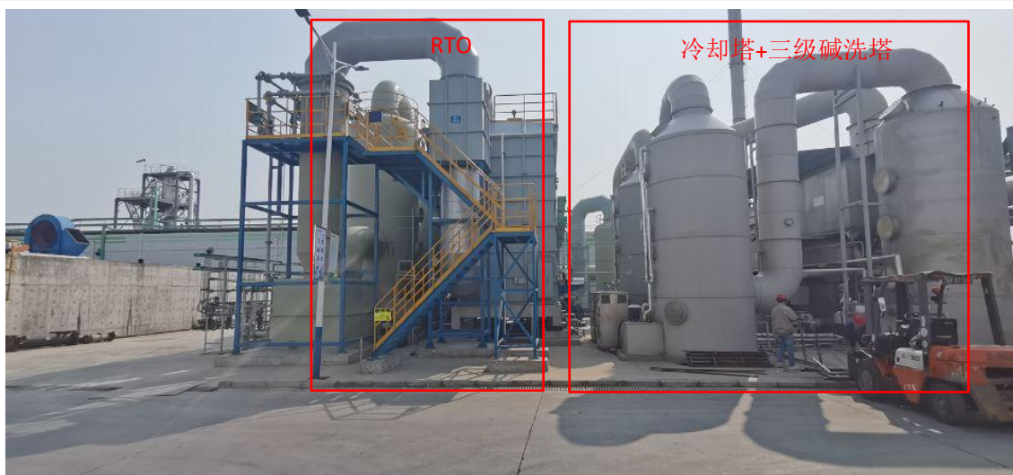
有机废气 RTO 处理
