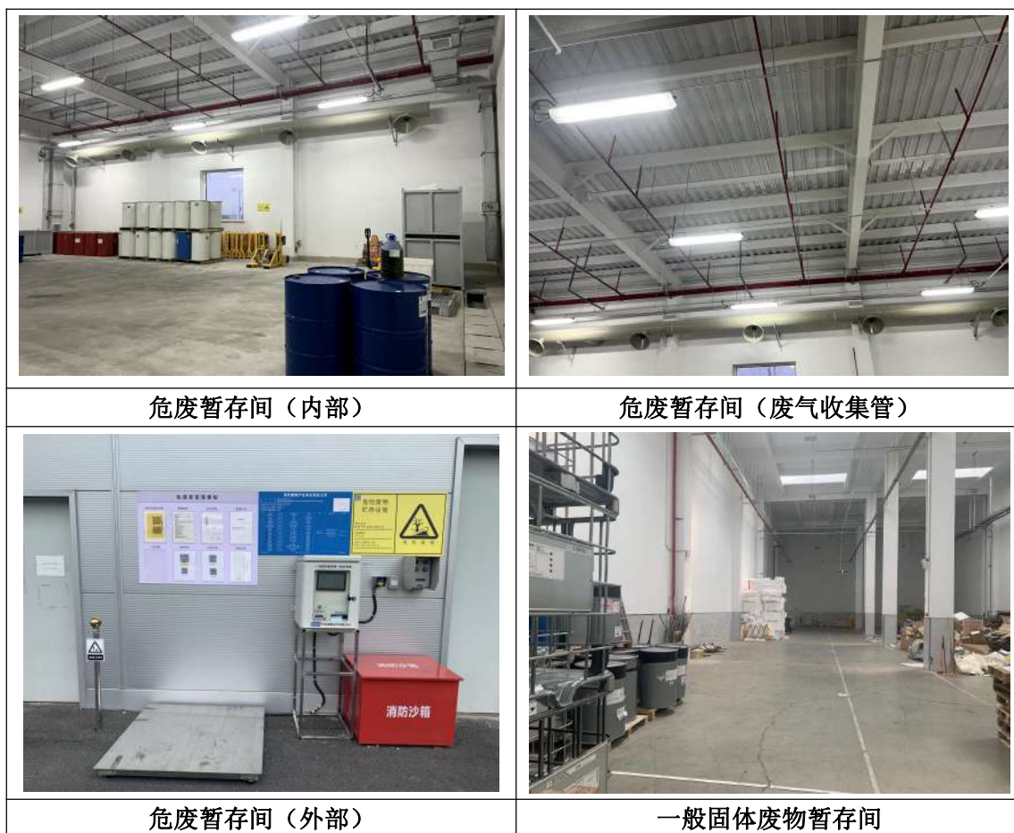
图 4.1-5 危险废物暂存间照片
