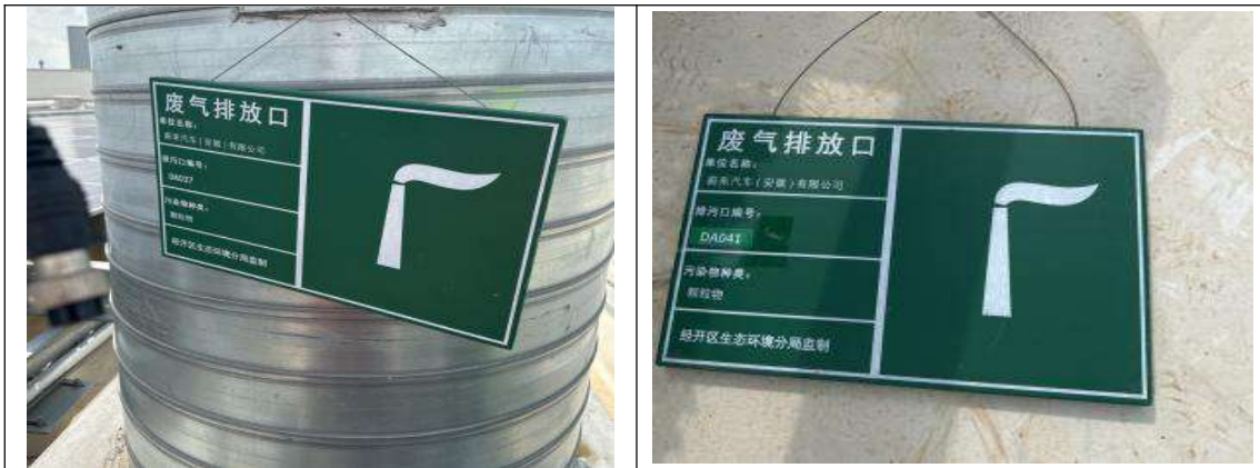
焊装车间电弧焊烟尘排气筒标识牌
