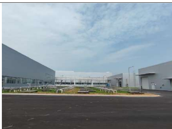
应急事故池（地下）
