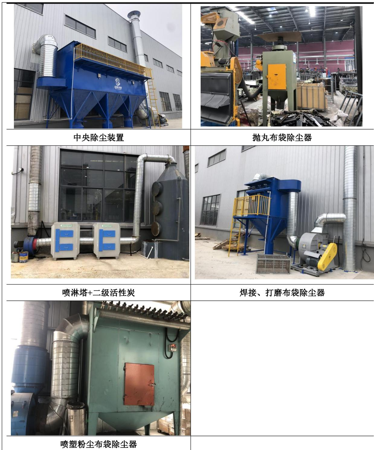
图 3.1-3 废气处理设施现场照片
