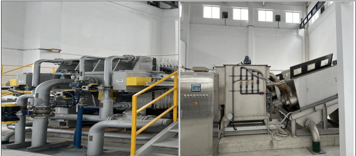
减震基座+设备安装在室内
