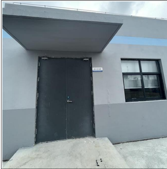
污水进口在线监控房
