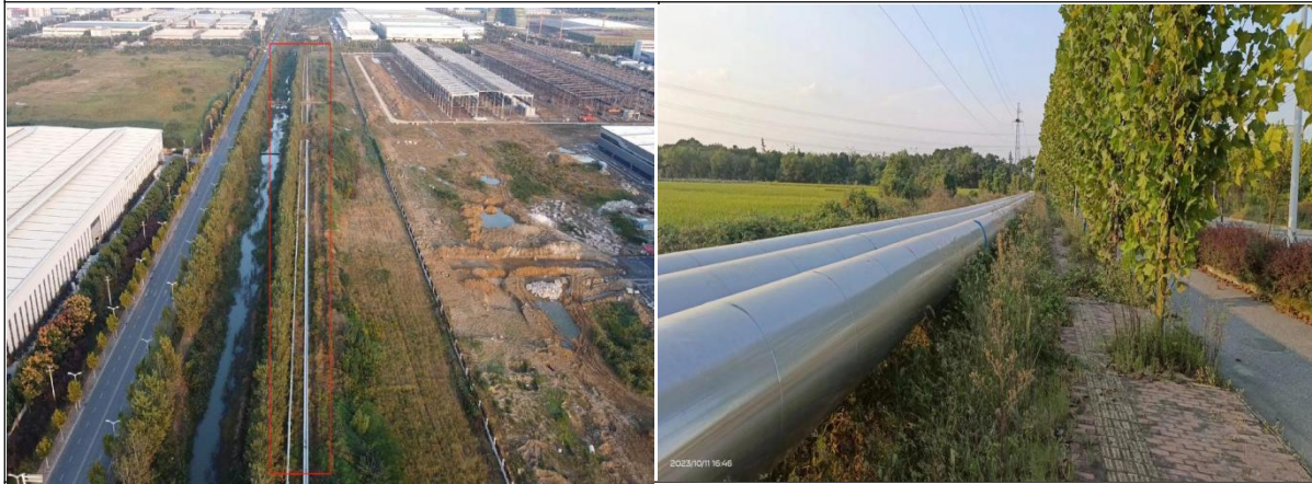
配套管网周边植被恢复
