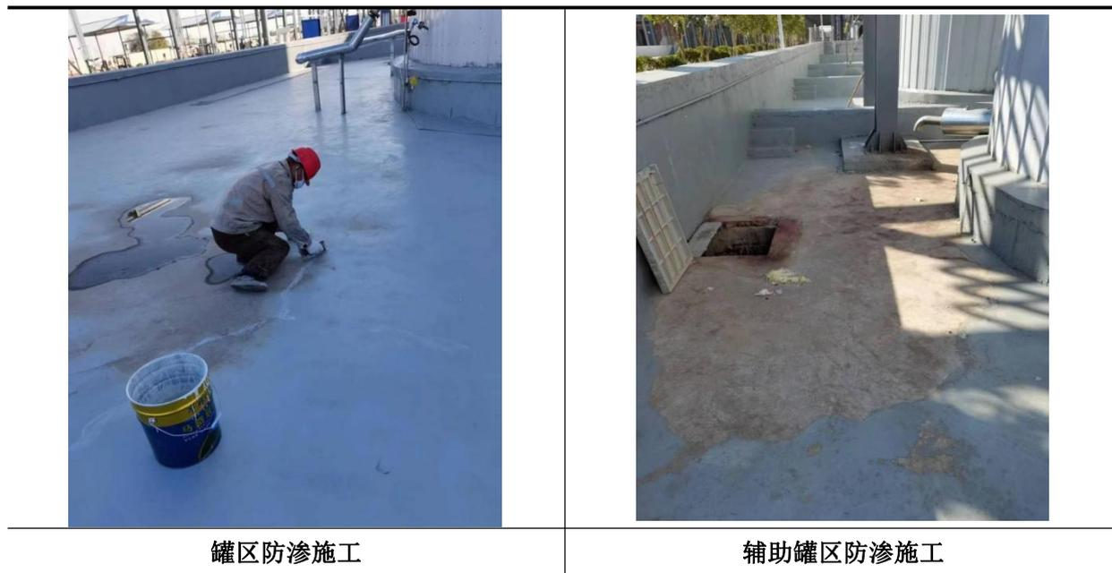
图 4.2-2 罐区防渗施工照片
