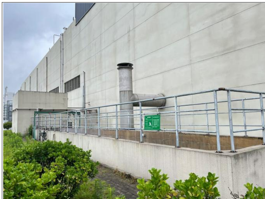
京东方污水处理站
