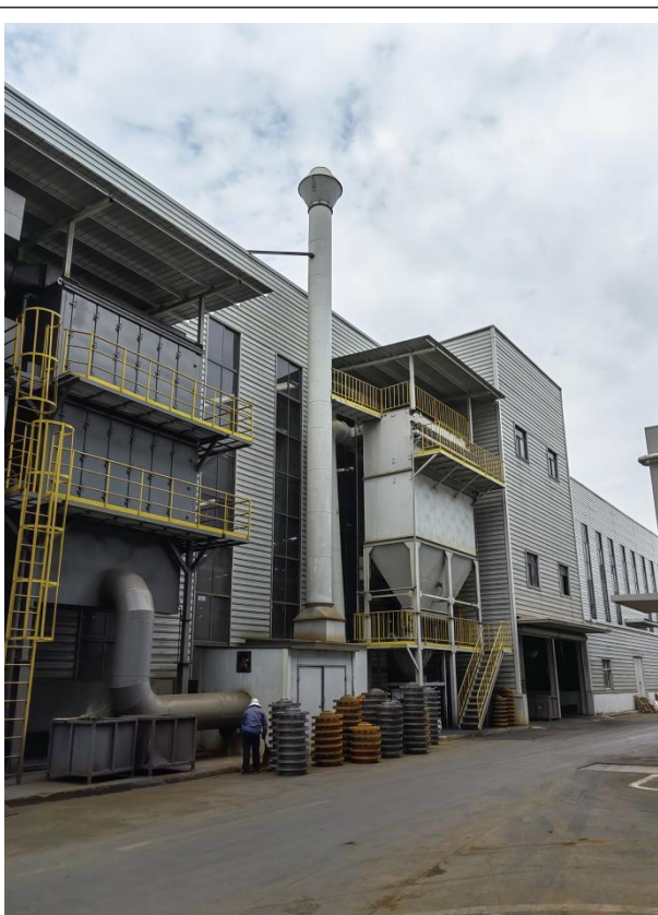
中频炉溶化废气处理设施及其排口
