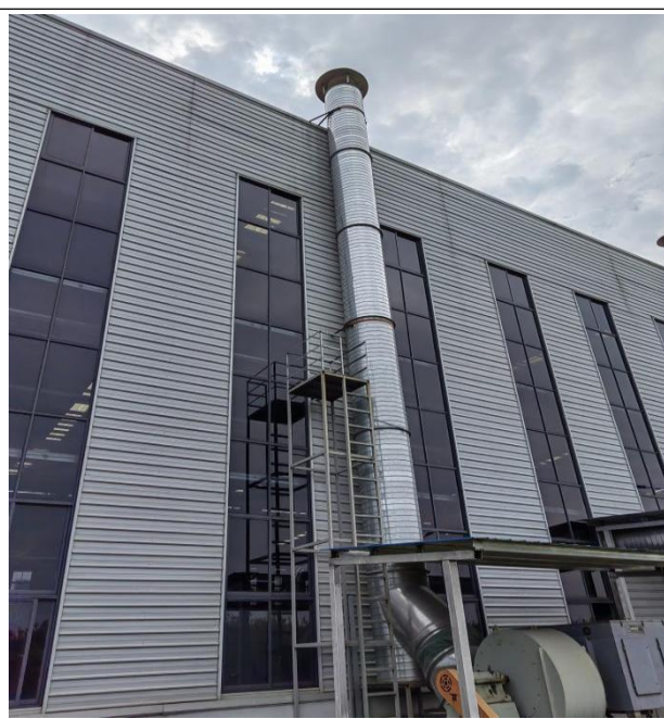
小件喷漆废气处理设施及其排口
