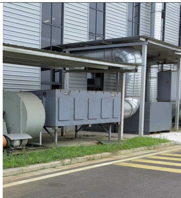
小件喷漆废气处理设施及其排口
