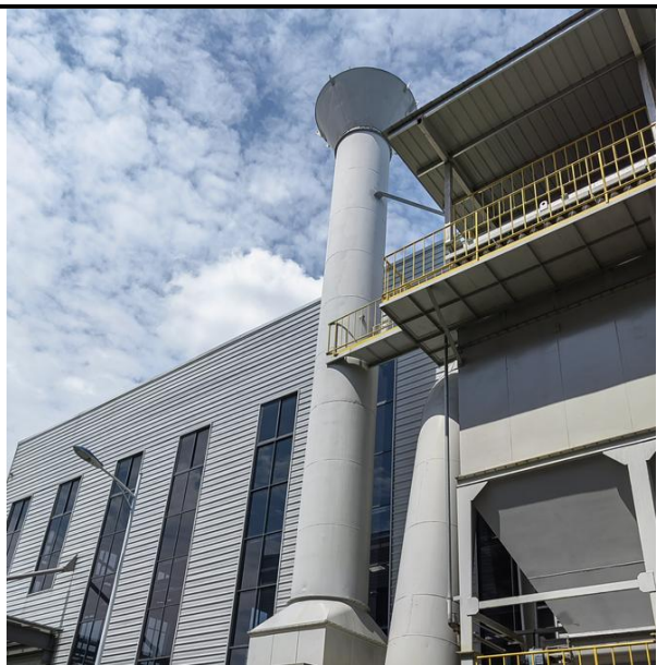
中频炉溶化废气处理设施及其排口
