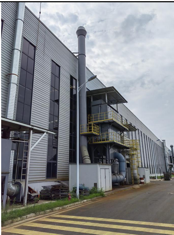
小件抛丸、打磨废气处理设施及其排口
