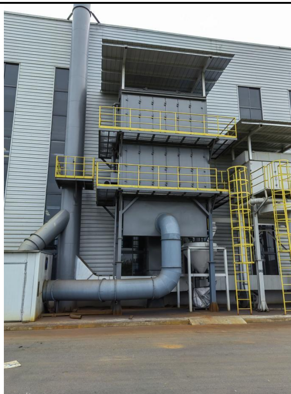
小件抛丸、打磨废气处理设施及其排口
