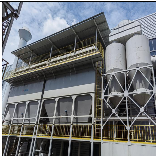
中频炉溶化废气处理设施及其排口
