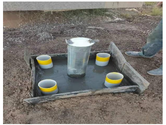
地下水监测井
