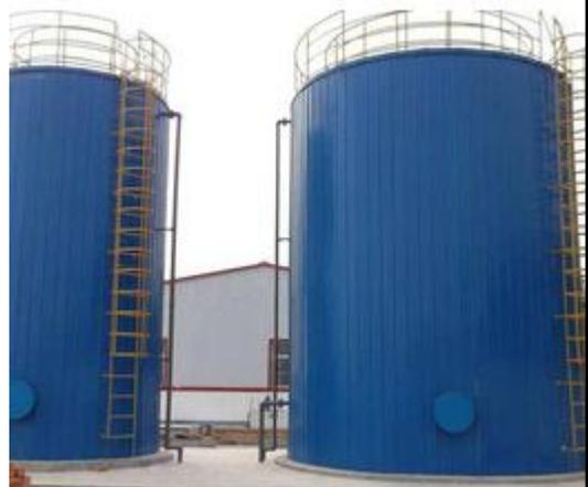
反应区经气体分离后的混合液进入沉淀区进行固液分离，澄清后的水由出水堰排出，沉降下来的微生物固体即厌氧污泥以自身的重力自动返回至反应区内，集气室收集的沼气则有沼气管排出反应器。UASB 改进了厌氧系统设搅拌装置于水下搅拌的过程，工艺中利用升流上升的水流和产生的沼气作搅拌功能作用。
