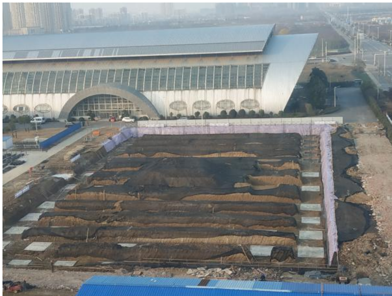
图 3-1（a）施工期间临时苫盖措施图
