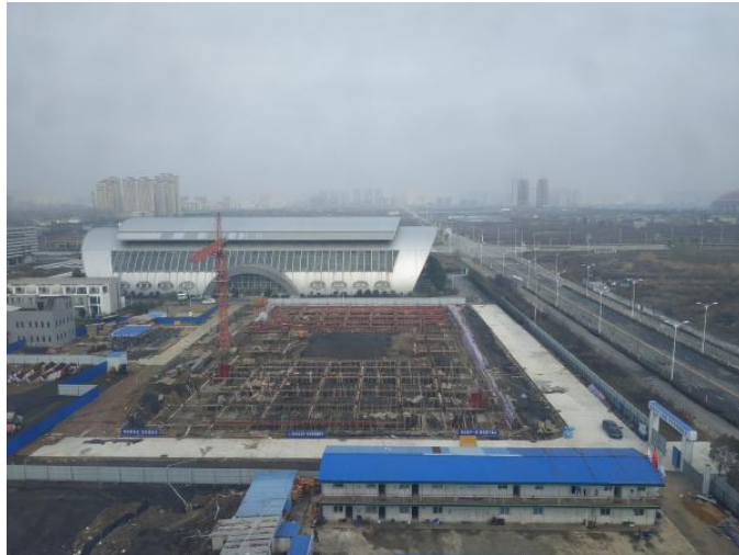
图 3-1 (b) 施工期间临时苫盖措施图
